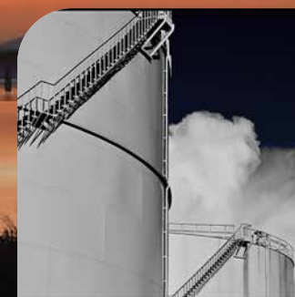
Cisterne di stoccaggio / Storage tanks
